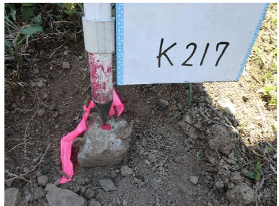
NO. 22 点名 K217 (先端破損したコン杭あり)
